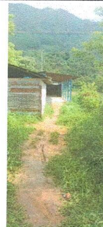
Foto 4: Remodelación de aula tipo portico
