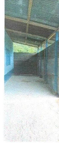
Foto 2: Reparación de losa de patio
