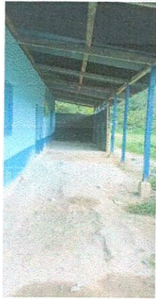
Foto 3: Reparación de losa de patio
