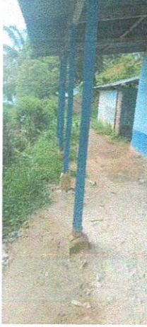
Foto 1: Reparación de losa de patio
