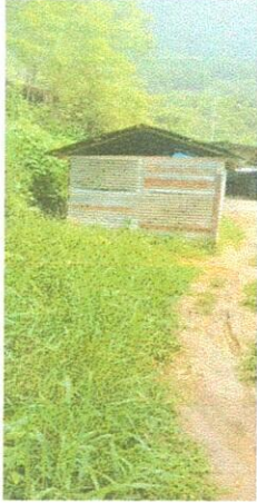
Foto 1: Remodelación de aula tipo portico
